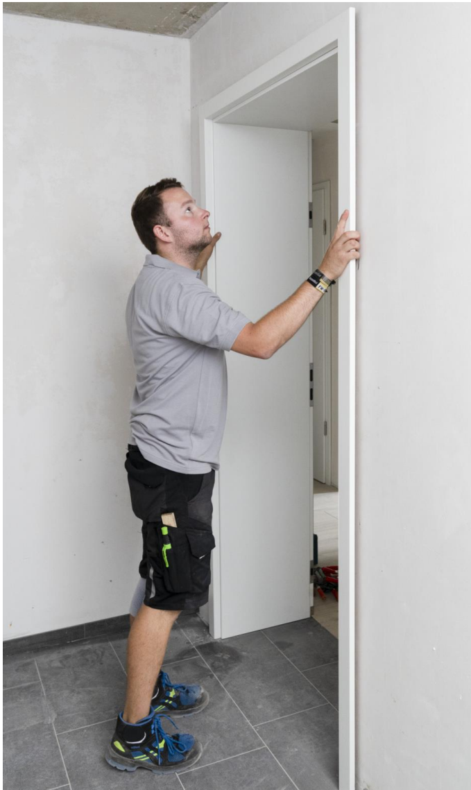
Bild 15: Wenn der Schaum ausgehärtet und überstehende Reste abgeschnitten sind, kann die Zierbekleidung eingesetzt werden. Dazu an sechs Stellen Leim in die Zargennut geben und die Zierbekleidung eindrücken.
